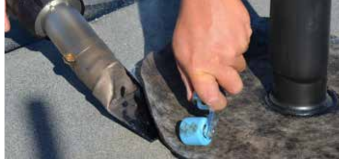
Sicheres Arbeiten mit Heissluft
