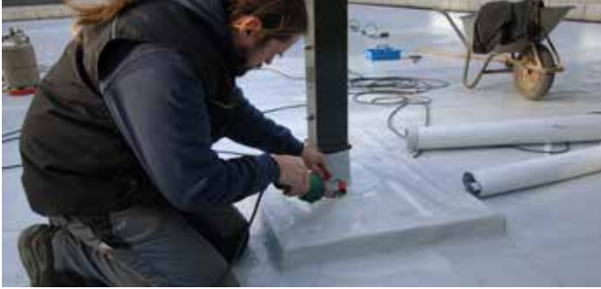
Handschweissen mit Kunststoff Dichtungsbahnen.
