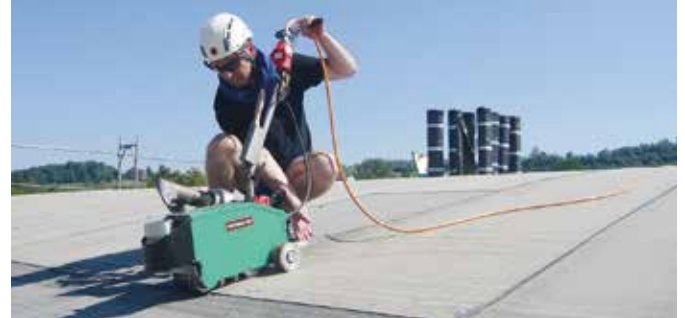
Der BITUMAT B2 schweisst Elastomerbitumen flammenlos.
