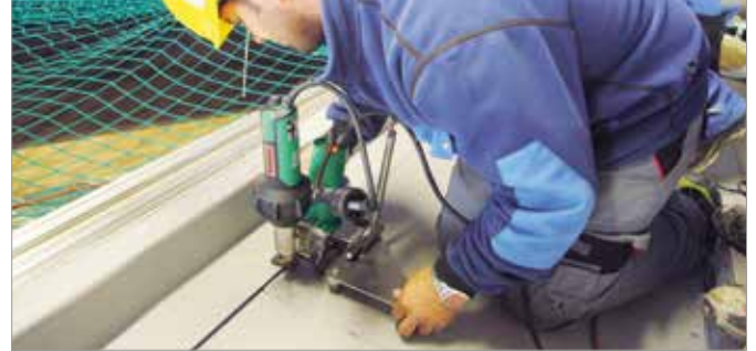
Mehr Stabilität und sichere Geräteführung mit der Führungshilfe.
