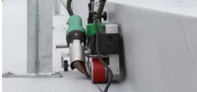
Mühe los schweisst der UNIROOF auch alle schwer zugänglichen „Dach-Problemzonen“
