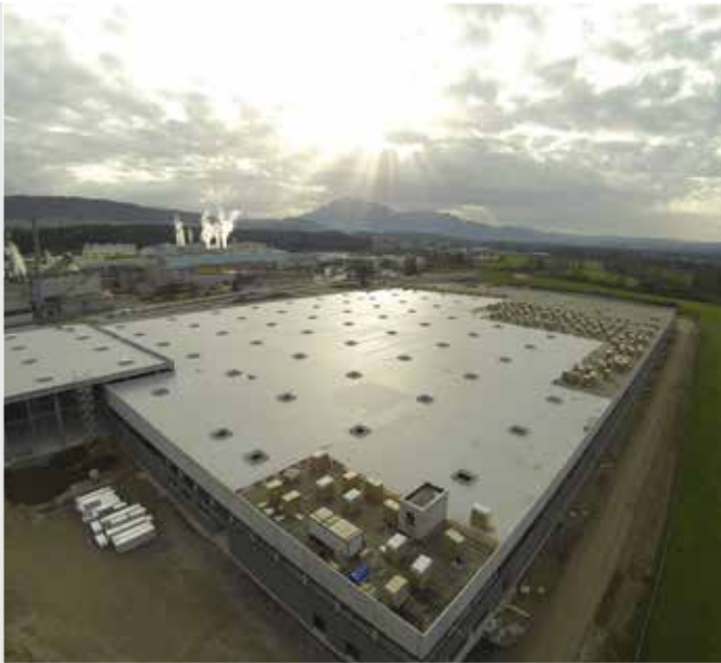
Aldi Logistikzentrum 50000m2 TPO Membrane, Schweiz
